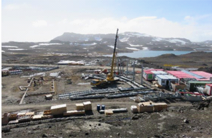
Detalle del avance de las obras.
