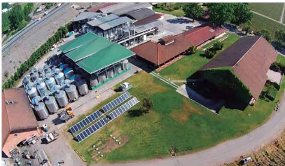
EL FRÍO DEL SOL. Sistema solar térmico para refrigeración por absorción en Viña Miguel Torres.
