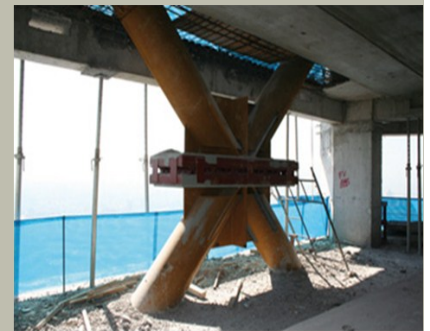
Imagen estructura antisísmica de la Torre Titanium
