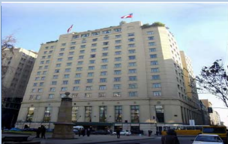
Edificio Carrera. Ministerio de Relaciones Exteriores de Chile.
